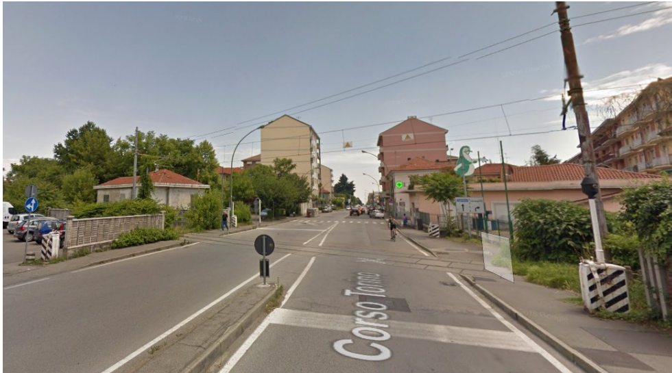
Passaggio a livello di corso Torino a Pinerolo. le sbarre del passaggio a livello sono state rimosse per ragioni di sicurezza (immagine Google)
